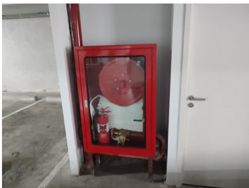
ภาพที่ 5-28 อุปกรณ์ป้องกันอัคคีภัย ตู้เก็บสายฉีดน้ำดับเพลิง และเครื่องกำเนิดไฟฟ้าสำรอง
