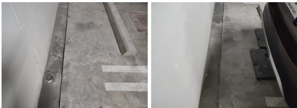
ภาพที่ 5-13 รางระบายน้ำรอบโครงการ ไม่พบว่ามีตะกอนอุดตัน
